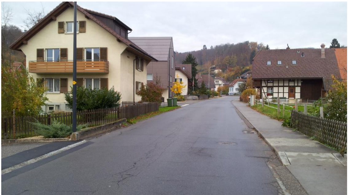
Abb. 1: Die Talstrasse heute: Der eingedolte Dorfbach (Betonabdeckungen) zur rechten Seite.
