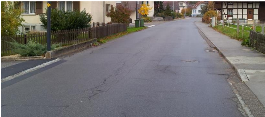
Abb. 2: Risse, Flicke und beschädigte Randabschlüsse entlang der Talstrasse.
