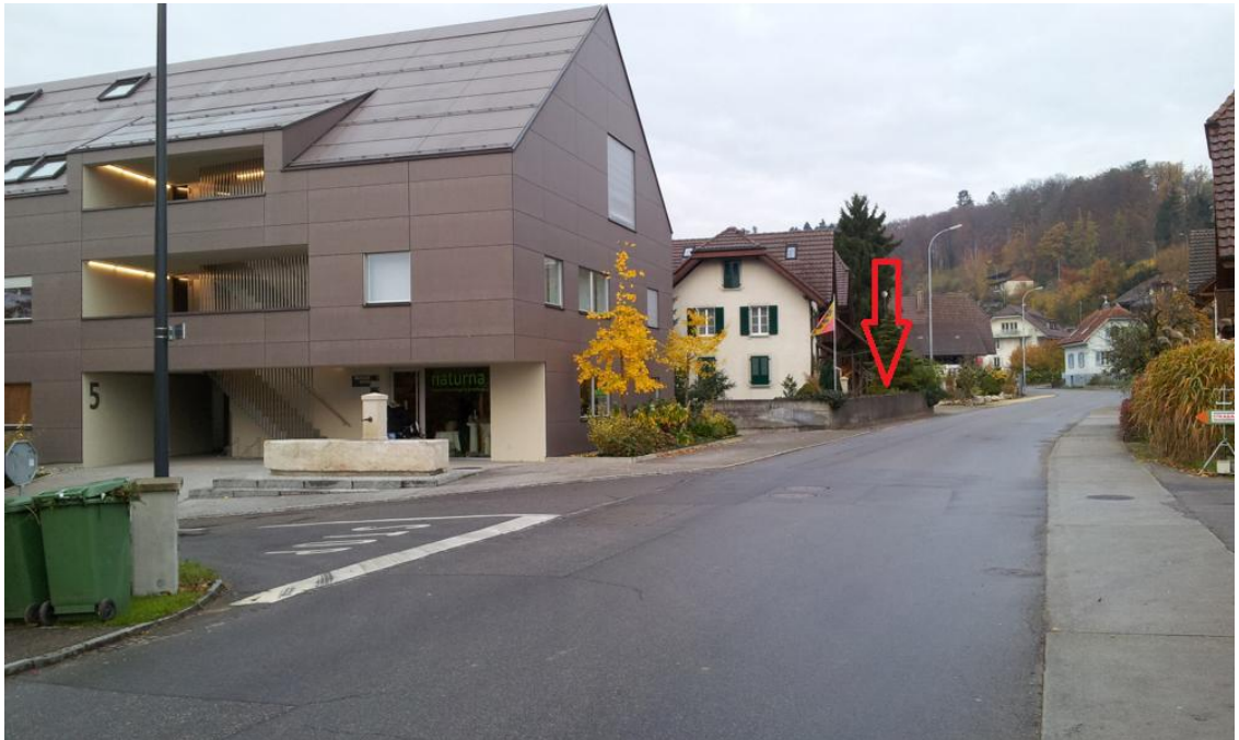
Abb. 3: Zu versetzende Mauer entlang der Parzelle 242.
