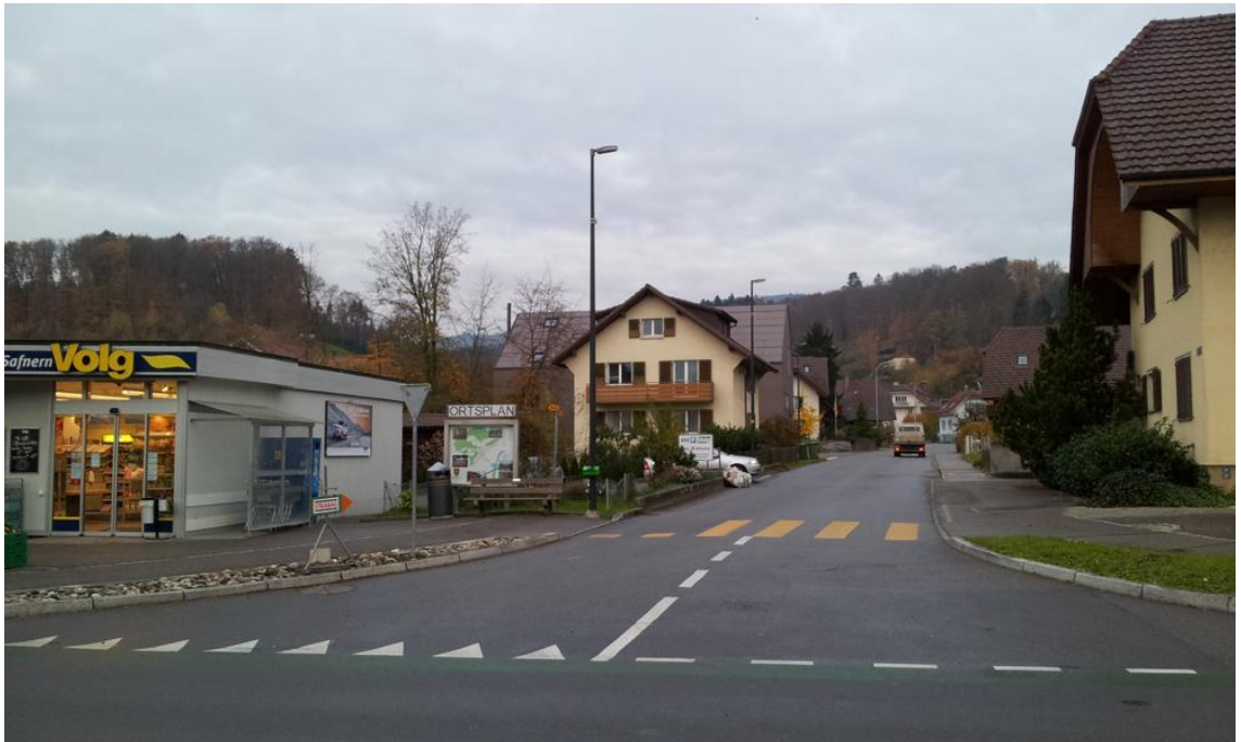
Einfahrtsbereich Hauptstrasse / Talstrasse, Projektbeginn
