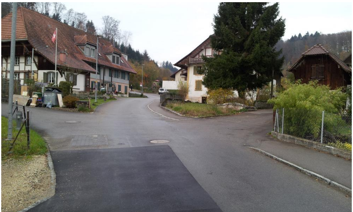
Bereich östlicher Knoten der Talstrasse, Projektende
